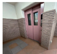
エレベーター
