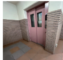
エレベーター
