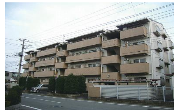
RC4階建て タイル張りマンション
