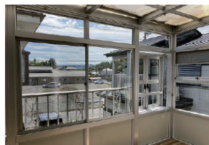
2F全面ガラス・サンルーム
