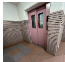
エレベーター
